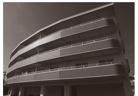
静岡市営住宅
